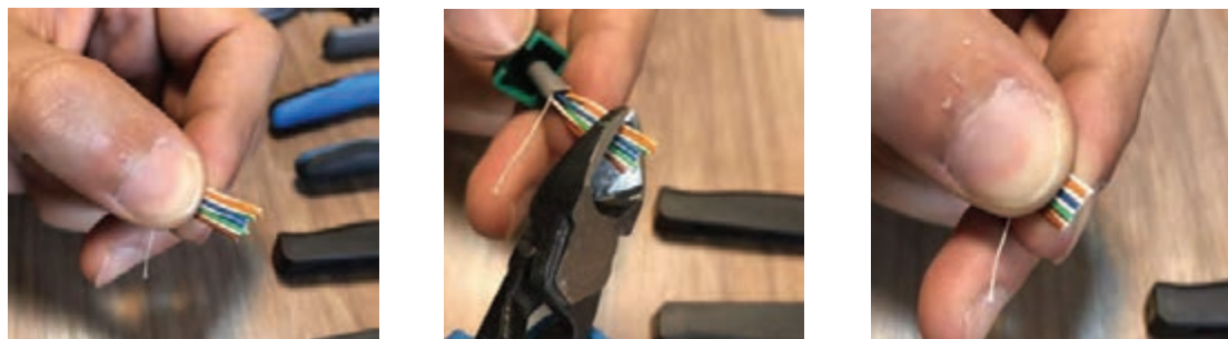
شکل ۲۷- مرتب کردن سیم‌های رنگی مطابق استاندارد
