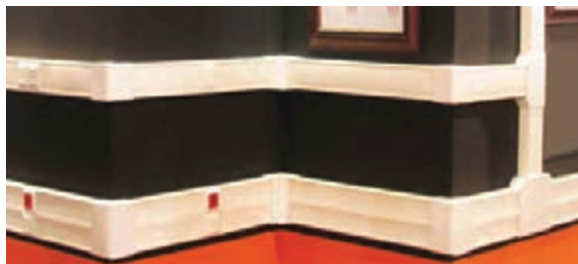
شکل ۵۳ - محل تقاطع ترانک‌ها و داکت‌ها
